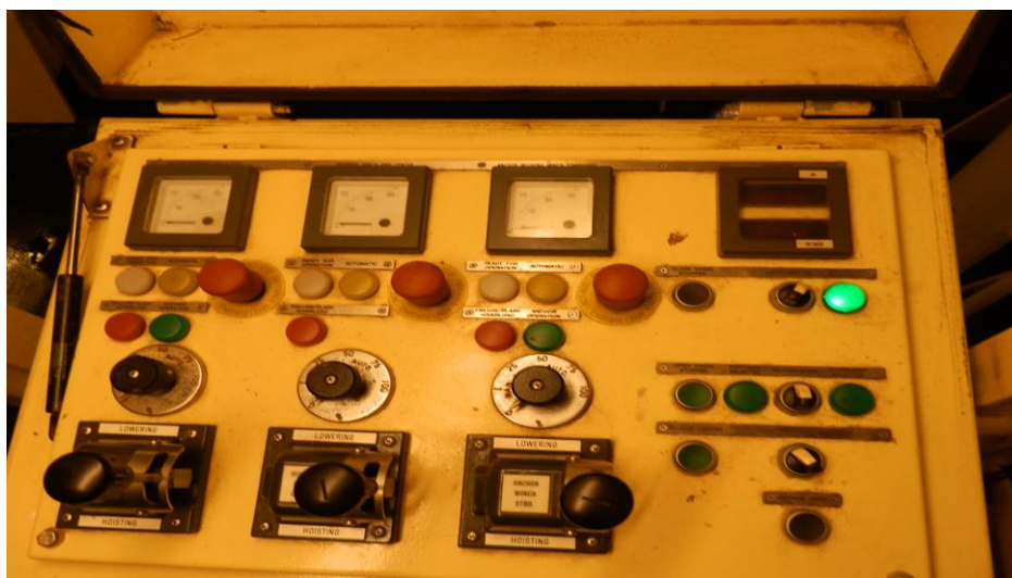
Εικόνα 16. Η κονσόλα ελέγχου στον σταθμό ελέγχου των βαρούλκων πρόσδεσης.
